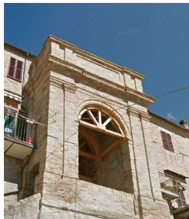
Foto. 7 - Vista dalla circonvallazione della porta e della della messa in sicurezza dell'arco oggetto di intervento di recupero.
