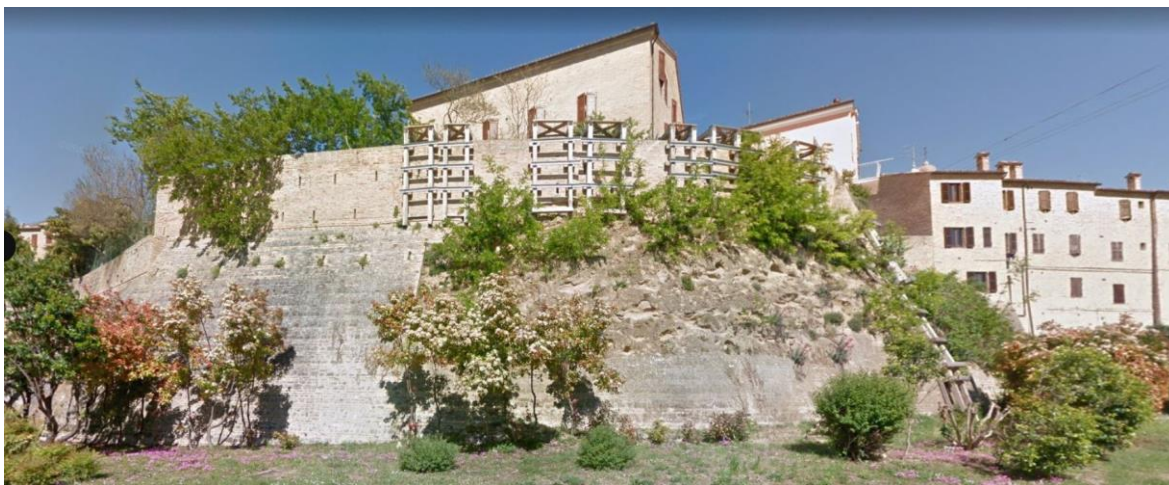
Foto. 13 - Vista dalla circonvallazione della cinta muraria e della messa in sicurezza di somma urgenza dell'oggetto di intervento di recupero.
