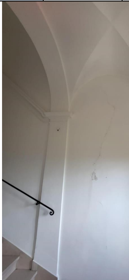
Fig. 4 – Foto del vano scala tra piano terra e dell'arco e volta a crociera.
