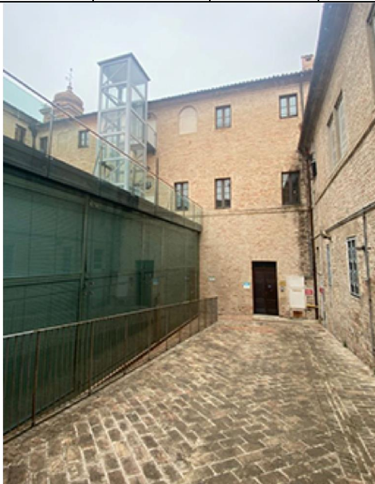
Fig. 5 – Ingresso di via Cavour, vista primo, evidenza dall'interno della corte.
